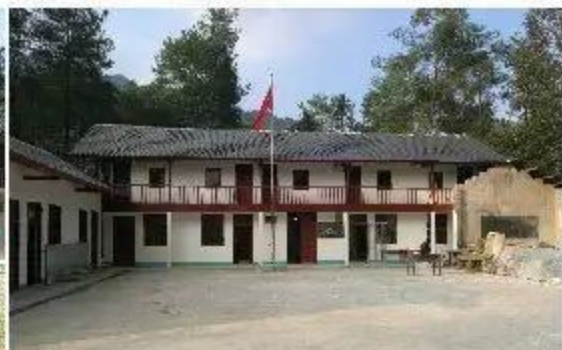
教学楼改造后
